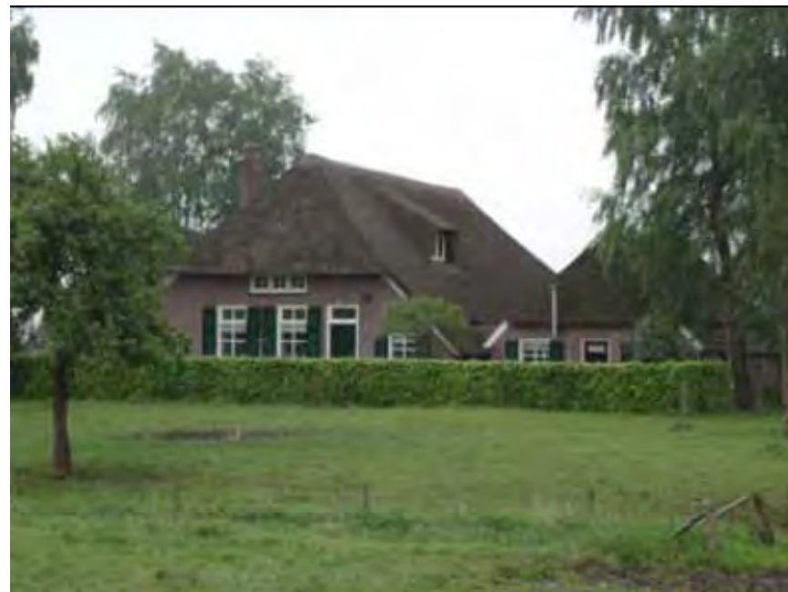
Karakteristieke bebouwing in Voorst
