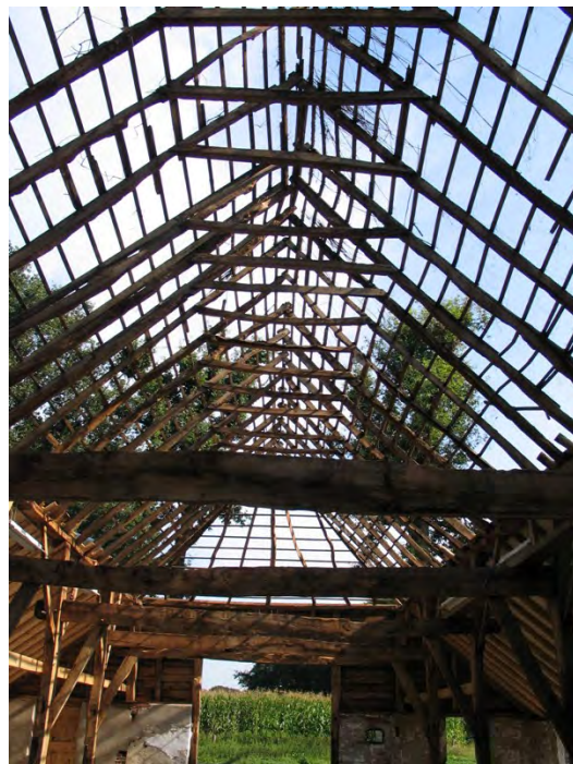
Kapconstructies vaak oudste onderdeel
