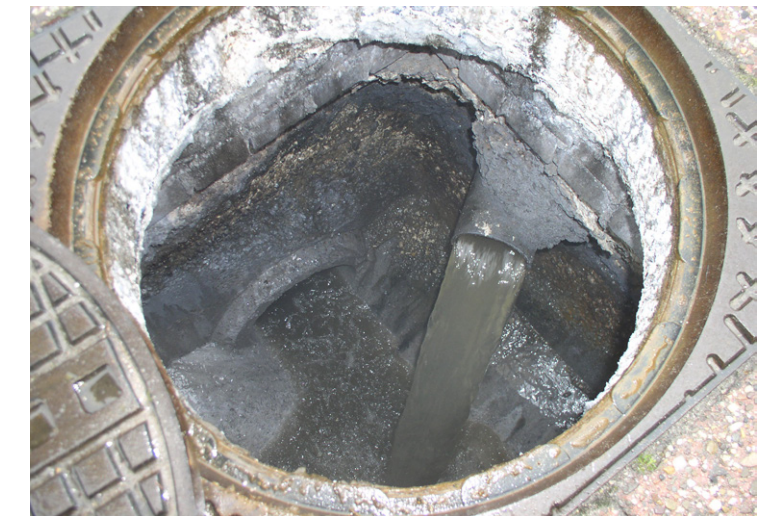
Gassen uit de drukriolering zorgen voor aantasting van beton.
