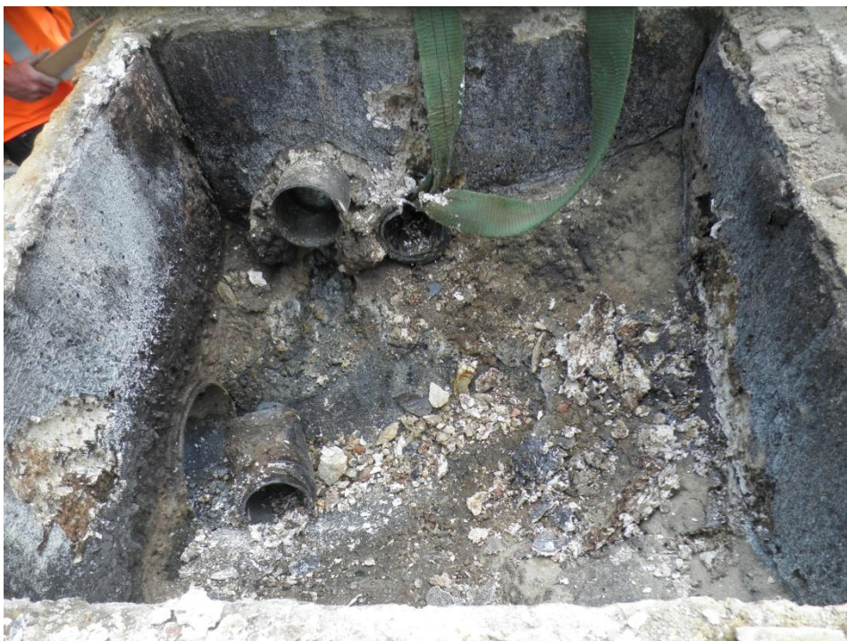
Figuur 6-E Aantasting door H 2 S in vrijvervalgemaal door lozing uit drukrioolstelsel
