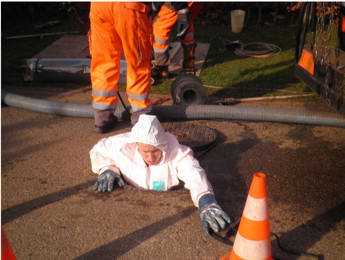
Figuur 4-F Rioolreparatie bij Appen
