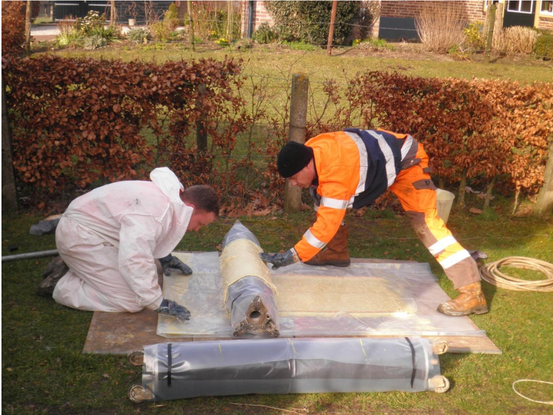
Figuur 6-B Deelliner die later nieuwe rioolbuis vormt
