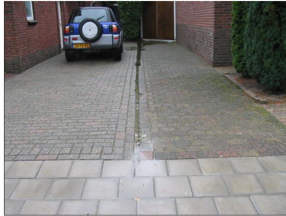
Figuur 4-E Afvoergoot hemelwater
