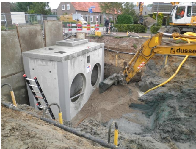
Figuur 2-A Aanleg bergbezinkvoorziening in Terwolde
