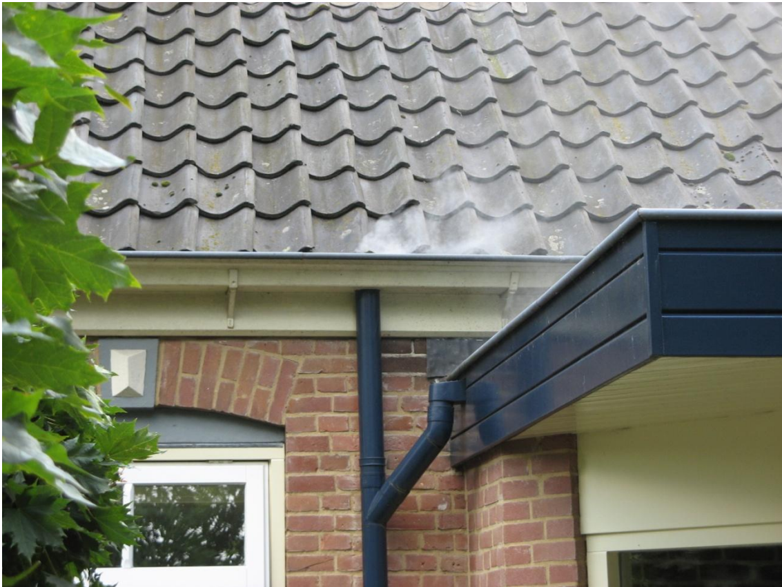
Figuur 3-E Onderzoek d.m.v. rook naar hemelwateraansluitingen op drukriolering
