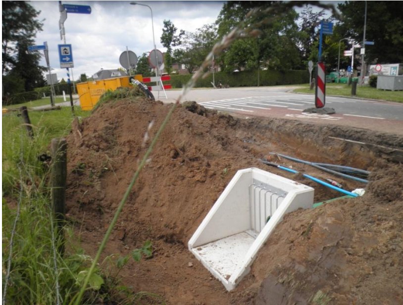
Figuur 4-B Regenwateruitlaat
