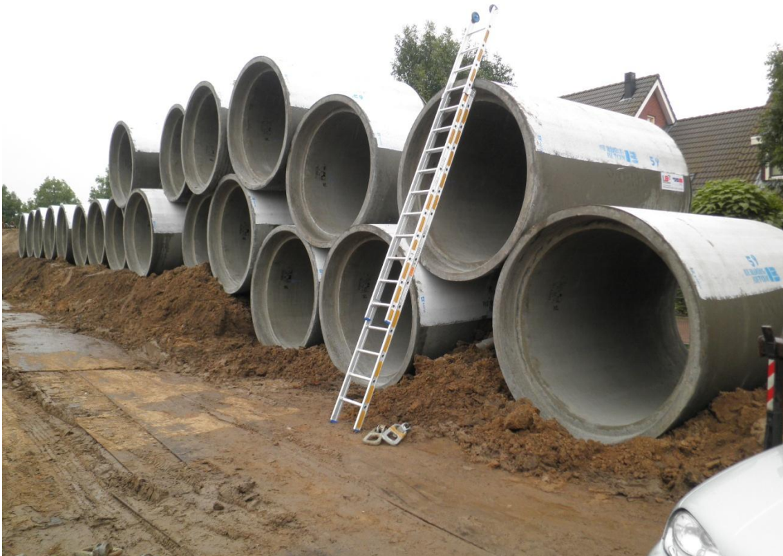
Figuur 4-A Riolorbuizen gebruikt voor de aanleg van een bergbezinkvoorziening
