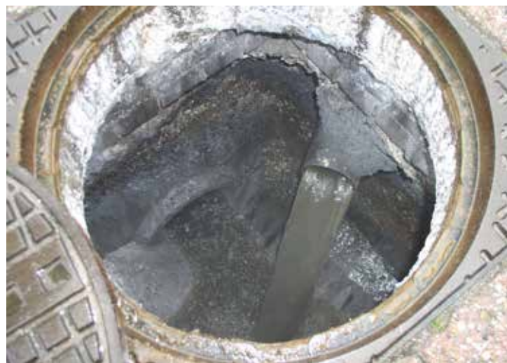
Gassen uit de drukriolering zorgen voor aantasting van beton.
