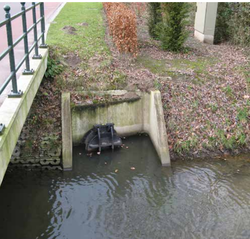
Gecombineerde vuilwater en regenwater overstort op de Fliert.
