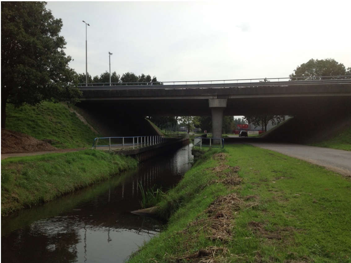
Foto bestaande situatie onderdoorgang Nieuw Schuilenburg
