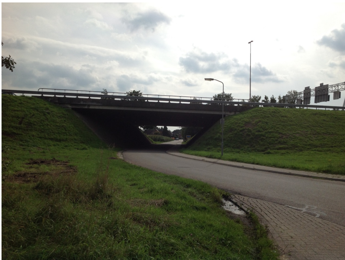
Foto bestaande situatie onderdoorgang Posterenk
