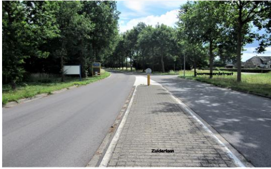
Foto 1: Begin Zuiderlaan in oostelijke richting
