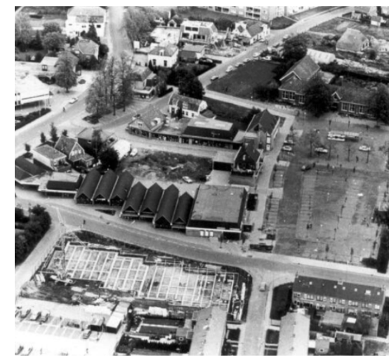
Van Ghentstraat vlak na de aanleg
