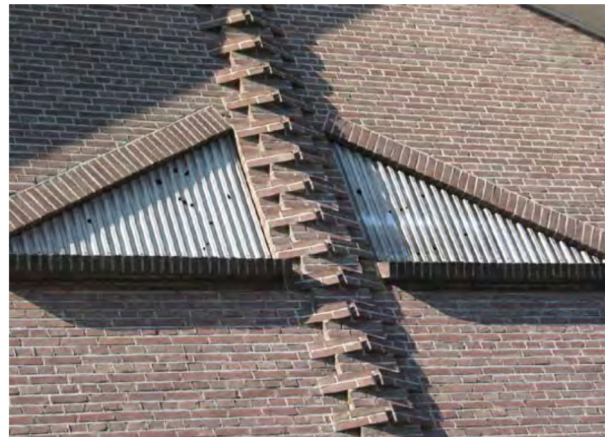
Geveldetail voormalig veilinggebouw
